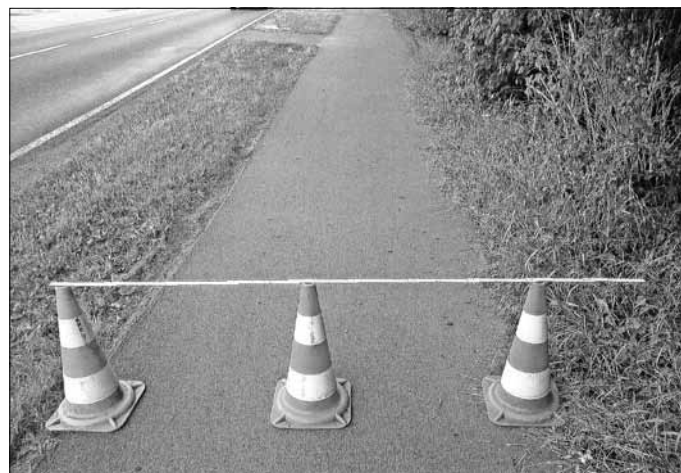
Ein Beseitigen einer Grasnarbe würde hier die Mindestbreite von 2 m ermöglichen, jedoch eine verkehrsbehördliche Anordnung gibt es nicht.
