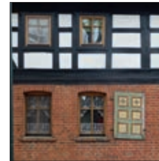
Nachgebildete historische Fenster mit historischem Fensterladen
