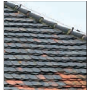
Dach mit Biberschwanzziegeln in Kronendeckung
