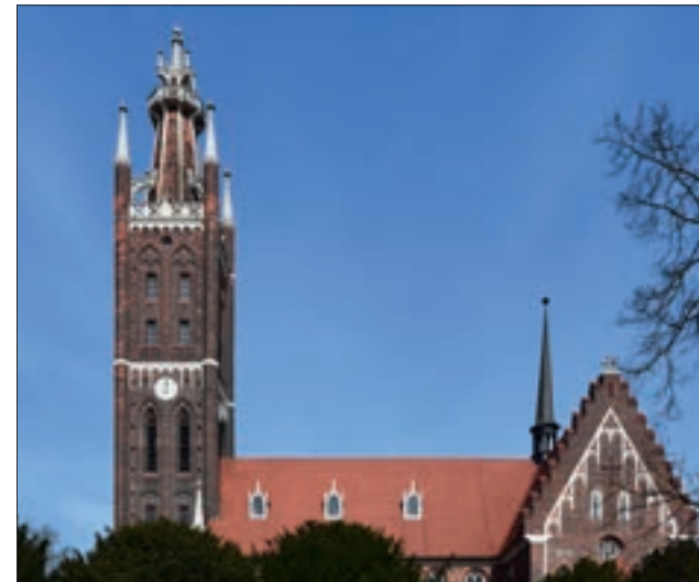
Weithen sichtbarer Turm der neugotischen Kirche
