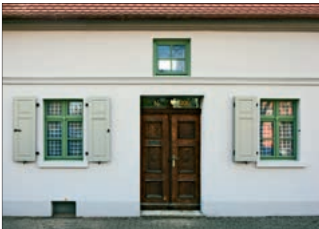
Klassizistische Fassadengestaltung mit schmalem Gesimsband und umlaufenden Fensterfaschen
