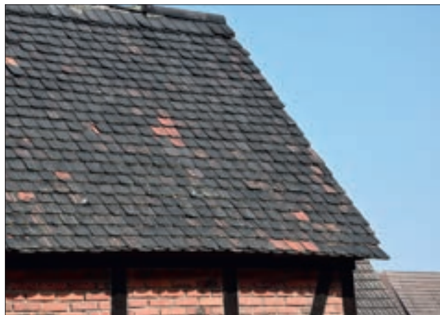
Dachdeckung mit Biberschwanzziegeln
