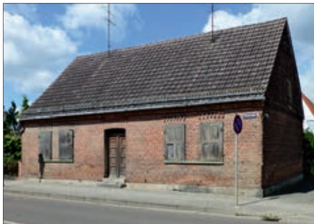
Wohnhaus mit ziegelsichtiger Fassade in spätklassizistischer Gestaltung
