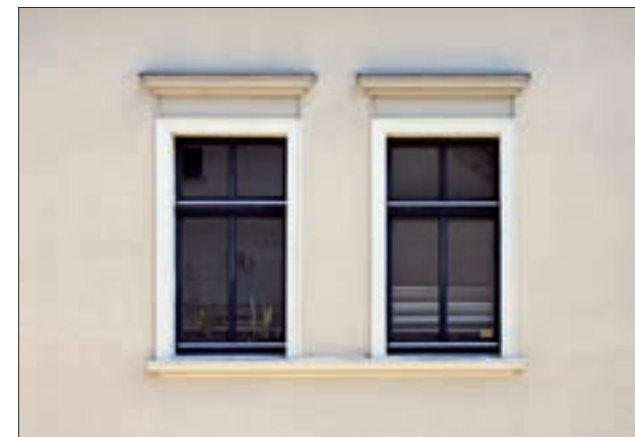
Spätklassizistisches Fenster mit durchlaufender Sohlbank der historischen Bebauung
