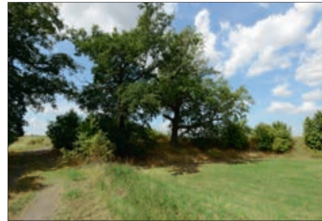
Historischer Deich mit Eichen zum Hochwasserschutz bei Vockerode
