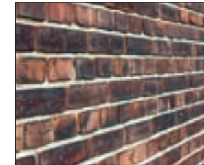
Typische Ziegelfassade mit Läufern und Bindern
