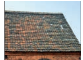
Einfache Biberschwanzdeckung auf einer Scheune des 19. Jahrhunderts
