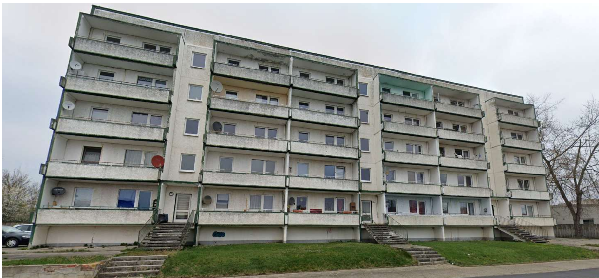
Abbildung 13 | freistehendes Mehrfamilienhaus (Baujahr ca. 1970) in Plattenbauweise
