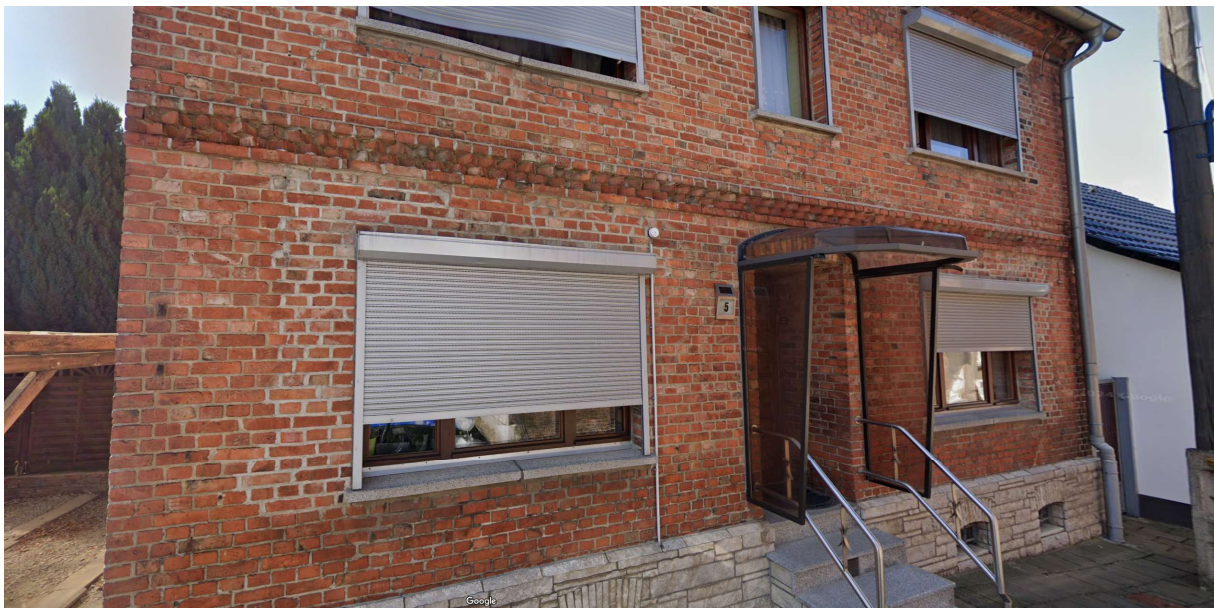
Abbildung 16 | freistehendes Einfamilienhaus (Baujahr ca. 1900) in Ziegelbauweise
